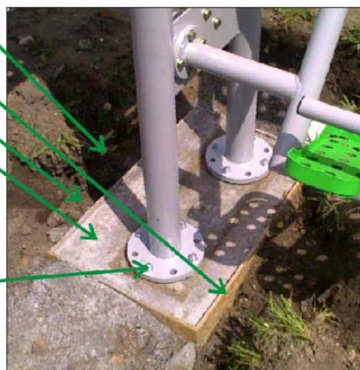
Rys. 59 Posadowienie pylonu urządzenia fitness w podłożu.
